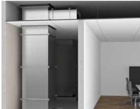
▼ Üfleme ve egzoz için büyük ölçülerde hava kanalları, shaft gereksinimi ve ticari değeri olmayan ölü hacimlerin oluşması
